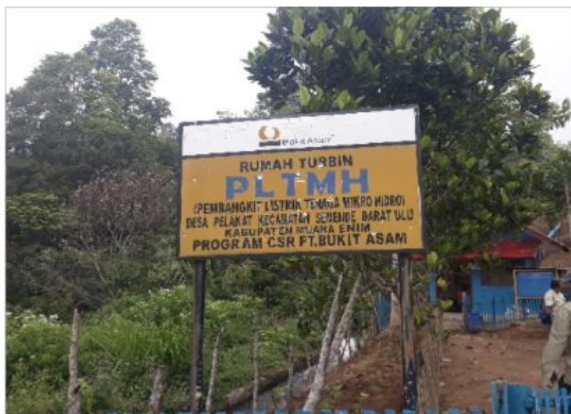
Rumah Turbin yang dirintis oleh Kohapa di Desa Pelakat.
